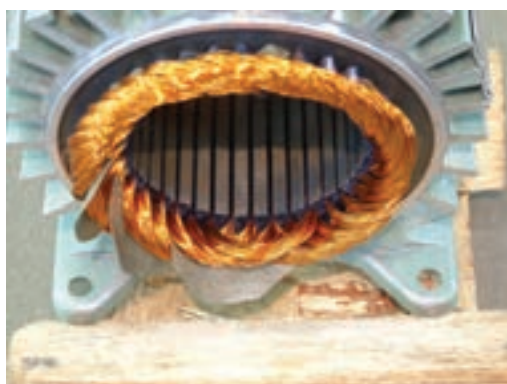
شکل ۲-۳۱- عایق کاری پیشانی کلاف‌ها
